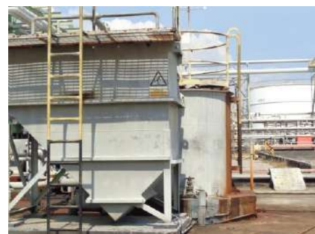
ภาพที่ 2.2-16 ระบบบำบัดน้ำเสียแบบ CPI ของโรงกลั่นน้ำมันหล่อลื่นพื้นฐาน (LBOP)
