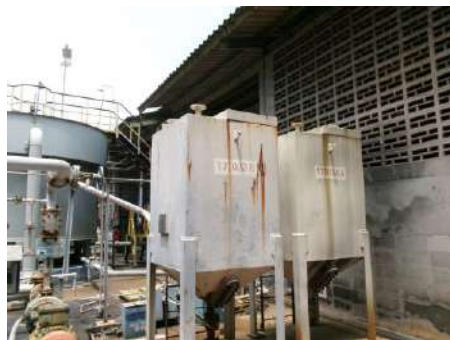
ภาพที่ 2.2-19 Slop Oil Tank เพื่อรวมครบน้ำมัน จากบ่อกักน้ำเสีย CPI/IAF
