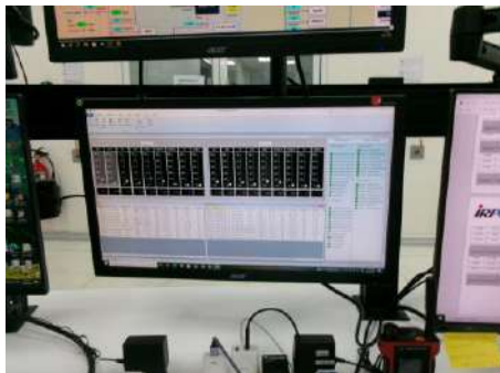
ภาพที่ 2.2-4 ระบบ CEMs ที่ปล่อง ADU2, Heater A (41B001A) และ ADU2, Heater B (41B001B)
