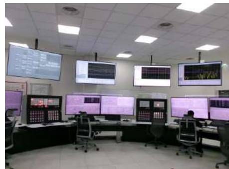
ภาพที่ 2.2-40 ระบบ Distributed Control System
